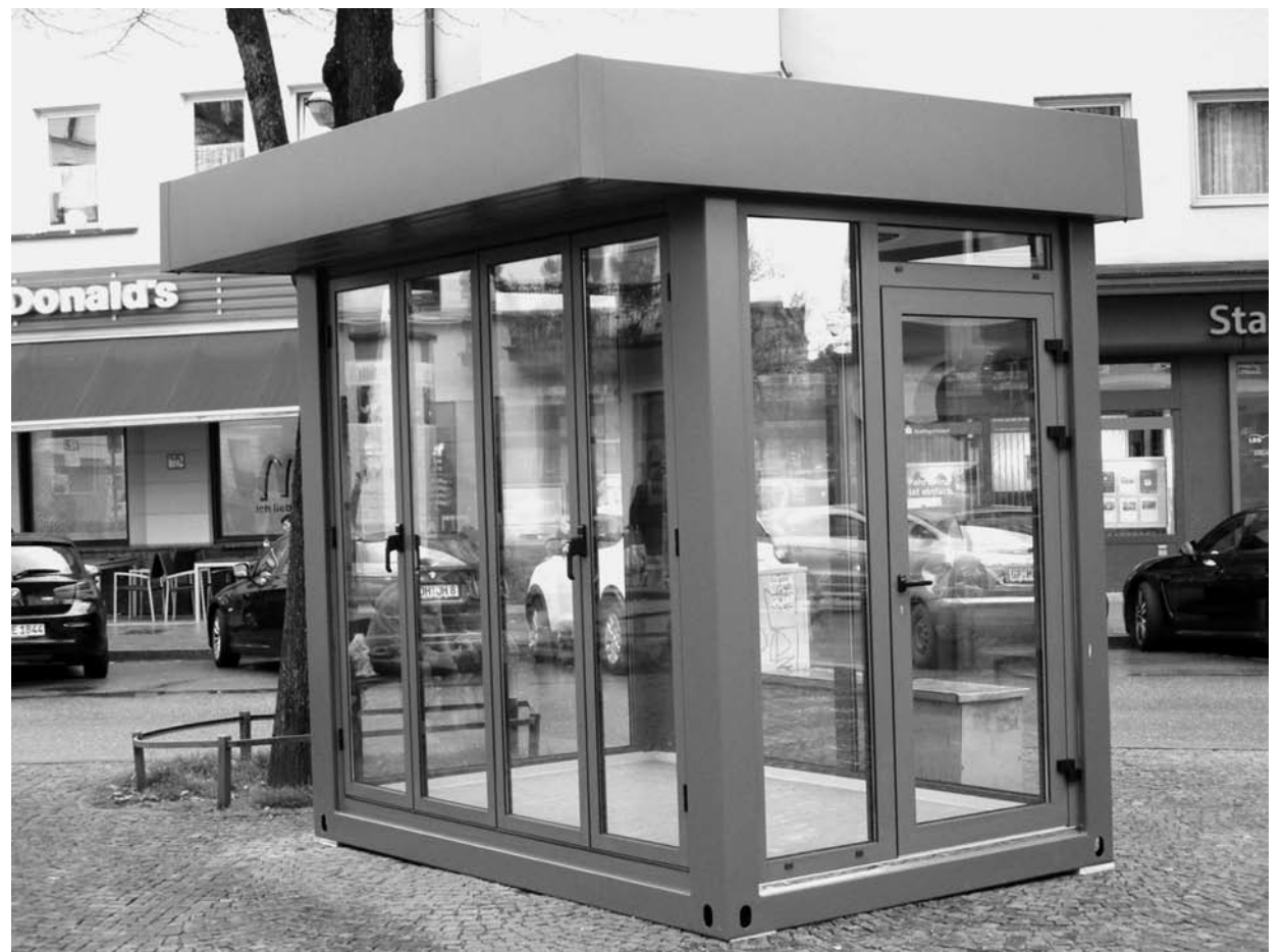
Bezugsfertiger Kiosk - der neue Glaspalast auf dem Pariser Platz
