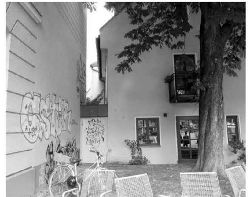
Grütznertstraße 8: Kein Platz auf öffentlichem Grund für eine Fluchttreppe. Foto: Haidhauser Nachrichten
