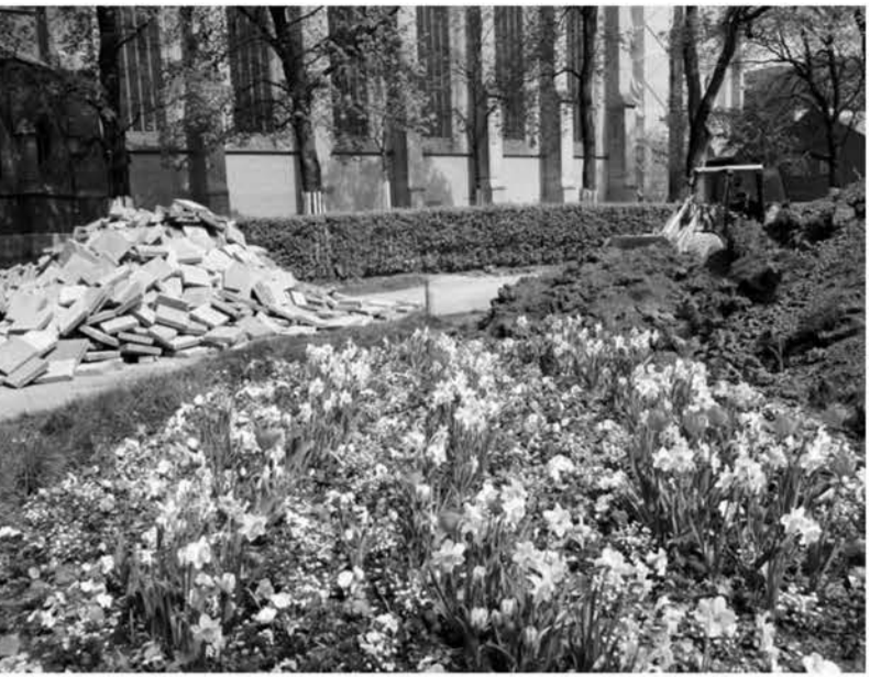
Baustelle Johannisplatz: Auf die städtischen Gärtner ist Verlass.
