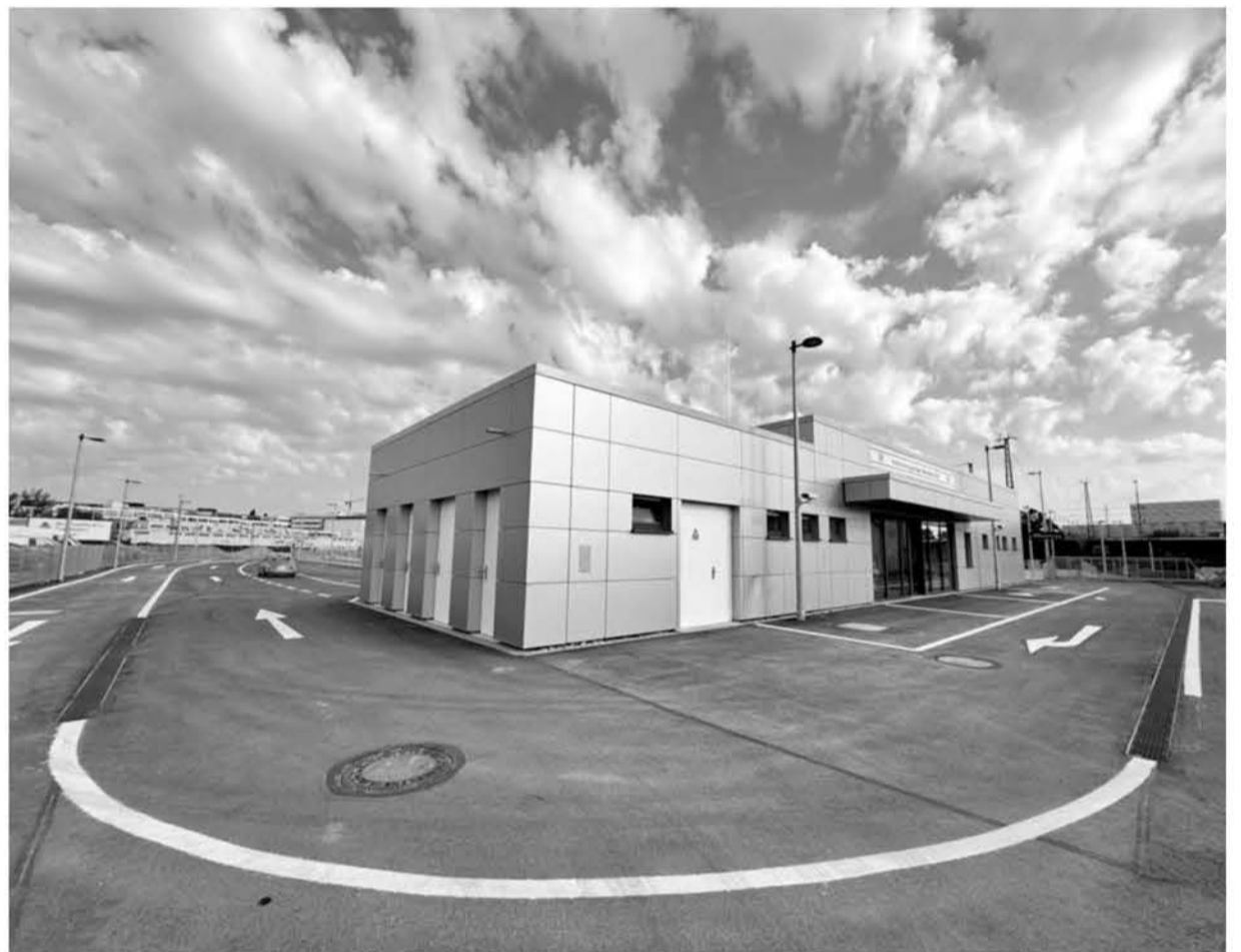
Um den Güterbahnhof im Schlachthofviertel autozugtauglich zu bekommen, wurde ein neues Terminal errichtet. Jenes am Ostbahnhof muss dem Tieftunnelprojekt der 2. S-Bahn-Stammstrecke weichen. Unser Artikel zum neuen Auto-Verladebahnhof lesen Sie auf Seite 7. Foto: Eduard Bopp
