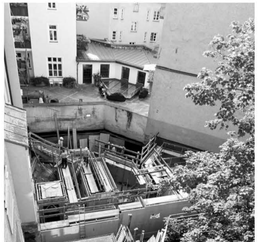
Nachverdichtung in der Breisacher Straße 5:
