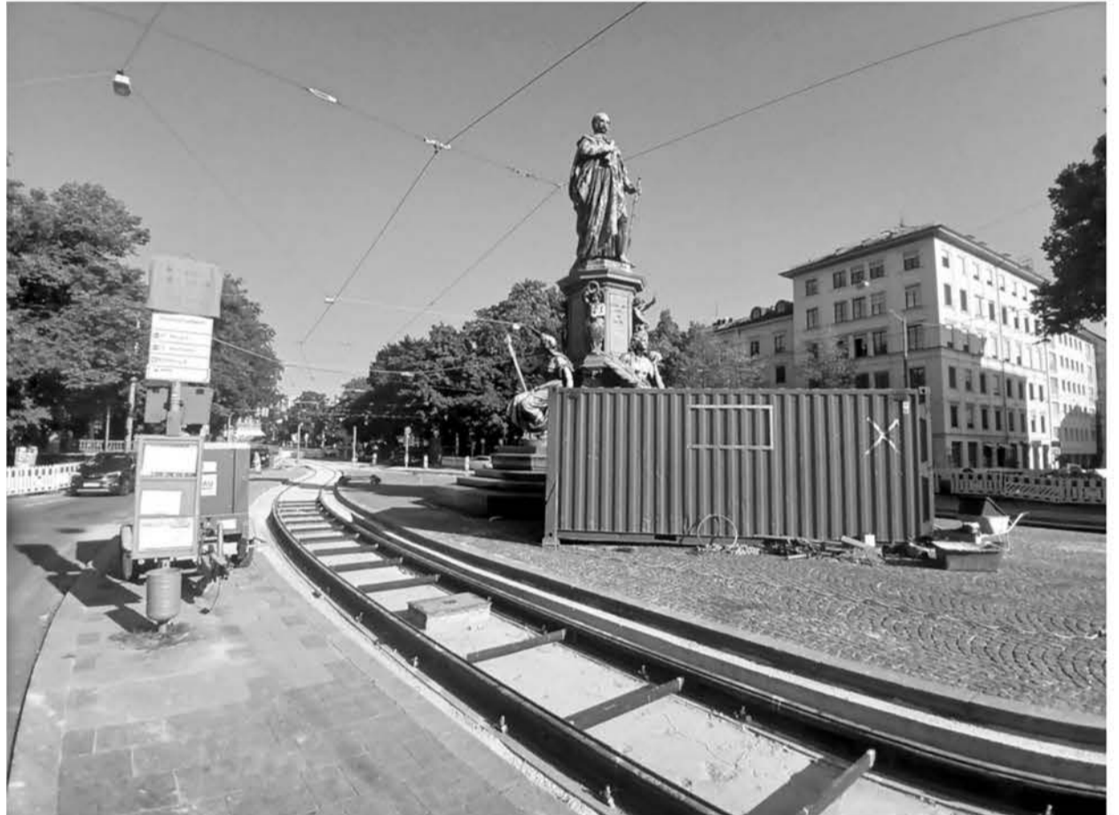
Stillstand in der Bauphase an der Trambaustelle Maxmonument: Wegen einer unerwartet zu tief liegenden Bodenplatte kam es hier zu Verzögerungen.
