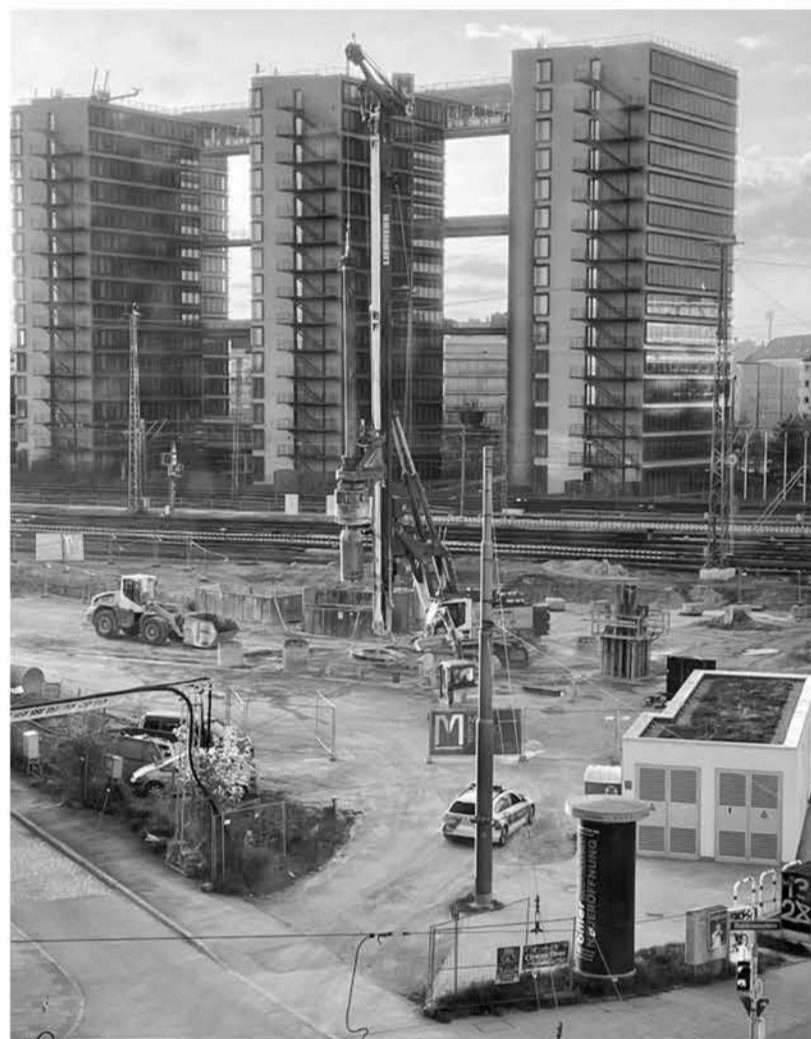
Durch die Bauarbeiten der Bahn für die 2.S-Bahn-Stammstrecke leiden die Anwohner schon in aller Früh unter erheblichem Baulärm. Nur die Bahn selbst, die schweigt. Unser Bericht dazu auf Seite 6 Foto: privat
