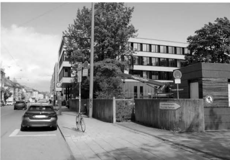
Ismaninger Straße: Klinikum rückt mit geplantem Neubau an den Gehsteig.
